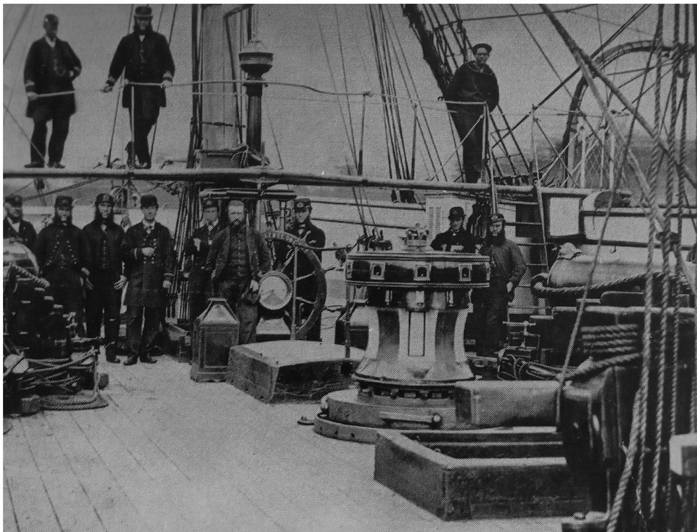
Abb. 1: Offiziere der HMS REINDEER in Esquimalt.. Die Abbildung ist zwar ein Single - Capstan, aber den unteren Pawlhead kann man gut erkennen. Aus: Andrew Lambert, *Trincomalee The Last of Nelson's Frigates*, Newbury, UK, 2002.
