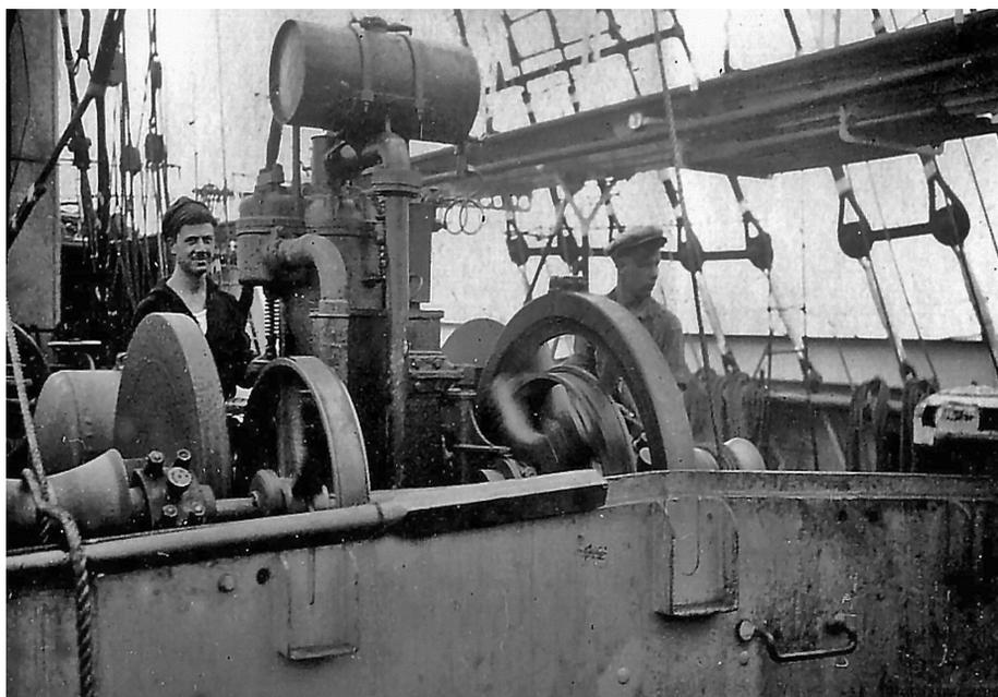
Abb. 2: Das Bild zeigt eine 10-PS Motorwinde beim Einsatz auf der Viermastbark PASSAT.
