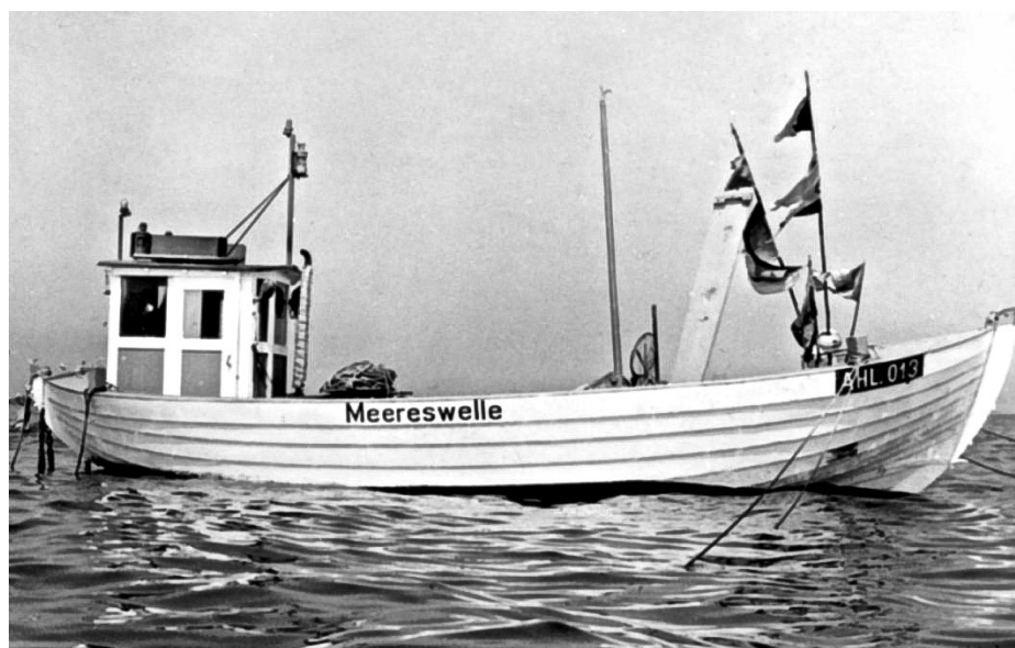
Abb. 3 oben: Strandboot MEERESWELLE mit Steuerhaus und deutlich zu sehenden, hier schräg stehenden, Steckschwert. (Bild: Archiv H. Olszak)
